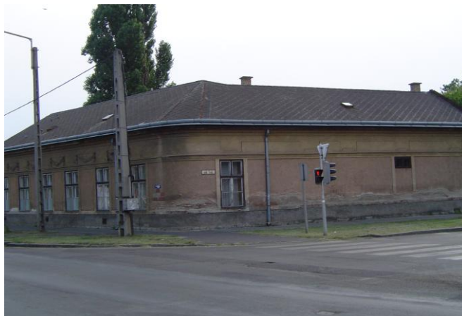
Szegényház téri oldaliskola, ma imaház 523
